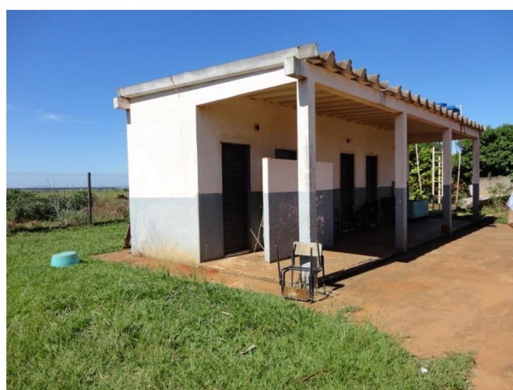
Figura 3: Lote da OMUS - Prédio lateral com banheiros (2012). Fonte: Acervo pessoal.
