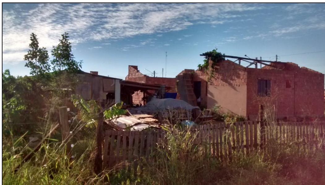
Figura 40 – Campo Grande-MS – Casa em construção no residencial José Teruel Filho (1 ano após a remoção) Foto: Marin, 2017
