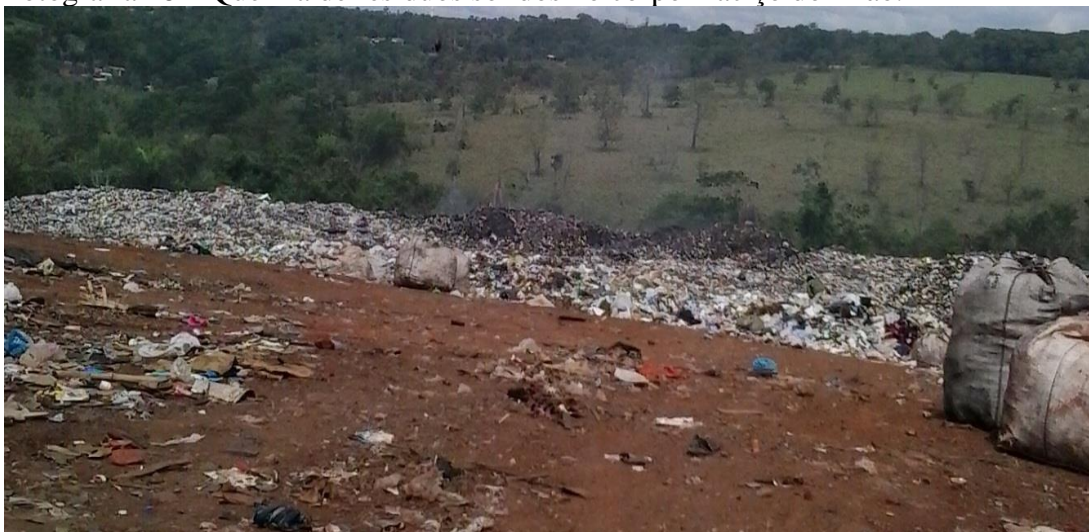
Fotografia 18 – Queima de resíduos sólidos no corpo maciço do lixão.
