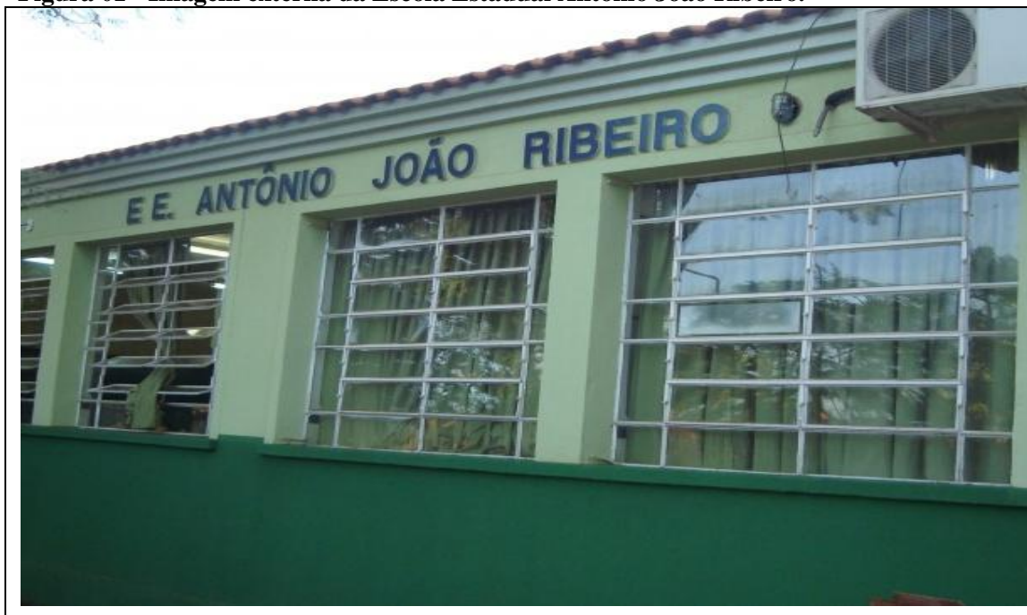
Figura 01 - Imagem externa da Escola Estadual Antônio João Ribeiro.
