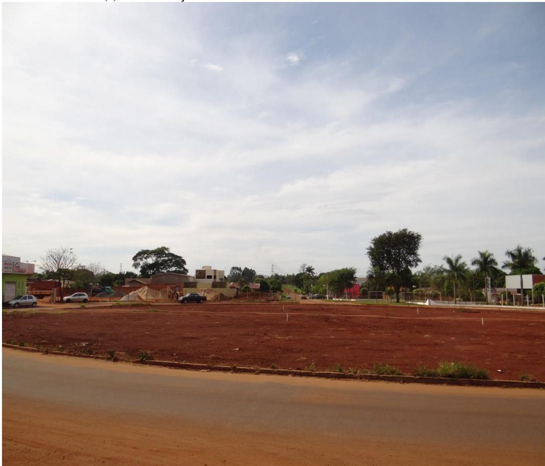
Foto 30 - O Início (?) da Construção do Terminal Leste
