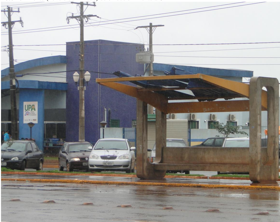
Foto 26 – Ponto (novo e danificado) de ônibus em frente a UPA
