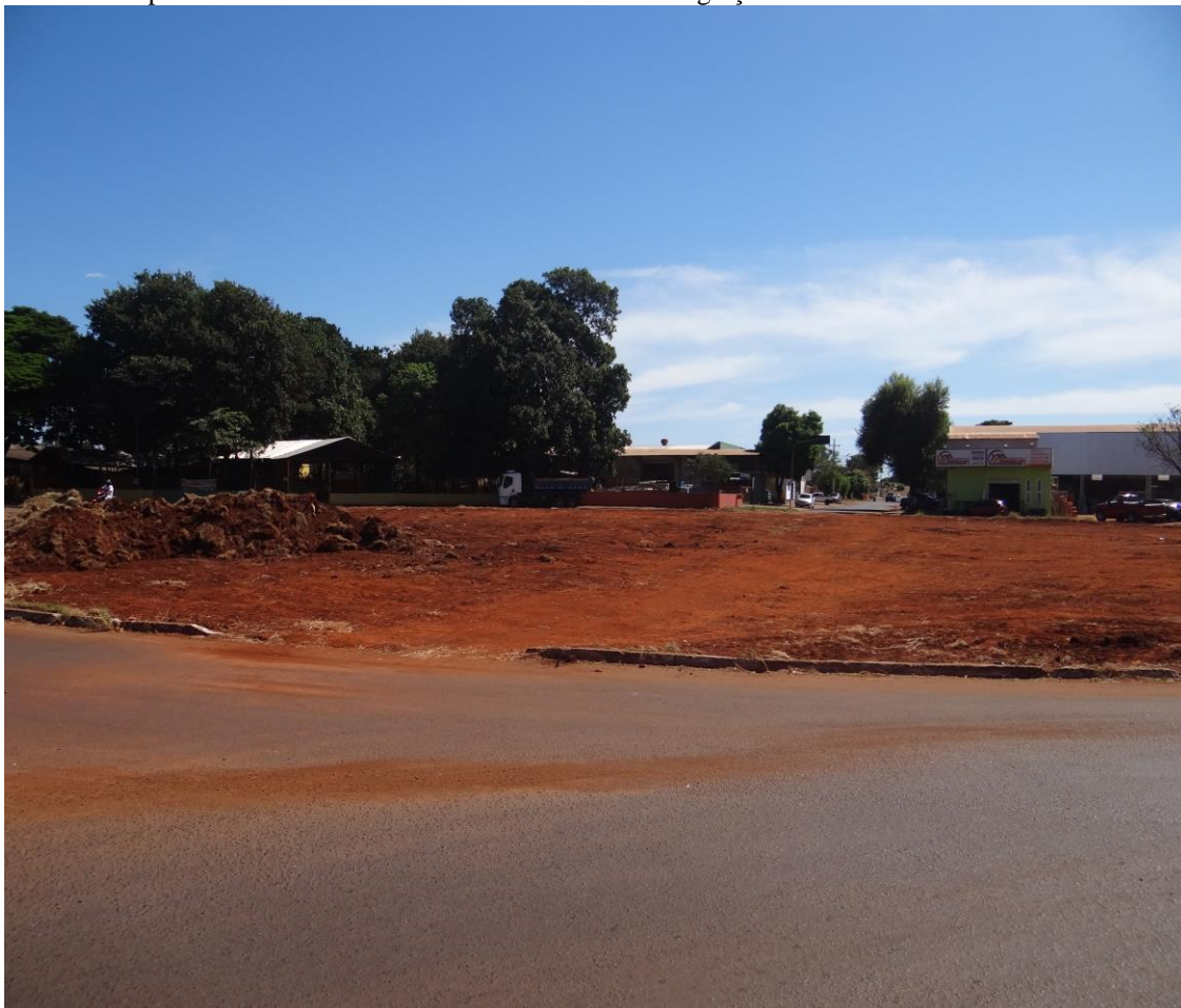
Foto 29 - Aspecto do local a ser construído o terminal de Integração Leste
