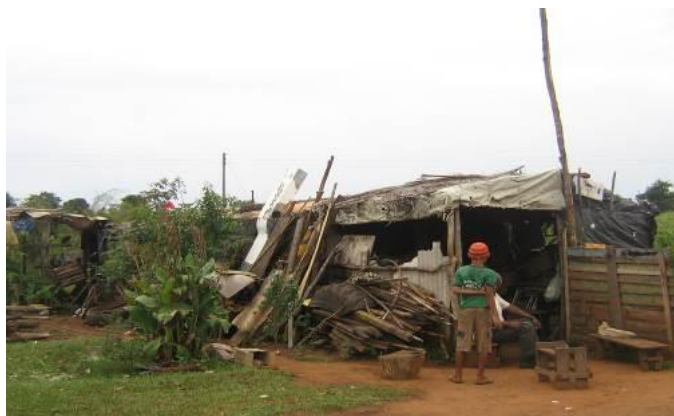
Foto 3 – Vista de um dos barracos improvisados com lona e restos de materiais de construção. Foto capturada pela pesquisadora, registrada no ano de 2006.
