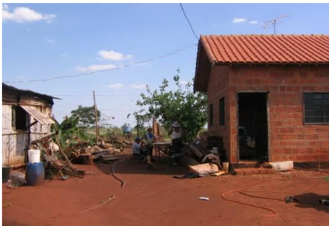
Foto 14: Casa em construção, localizada ao lado do antigo barraco de madeira. Fotos registradas pela autora no ano de 2010.
