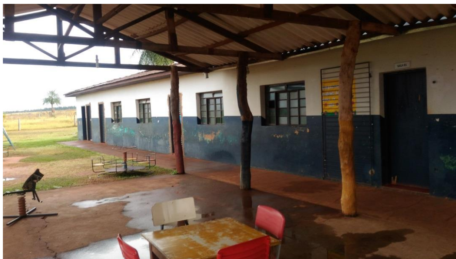
Foto 1 - Escola do Assentamento 17 de Abril - Extensão. Em 16/05/2018.
