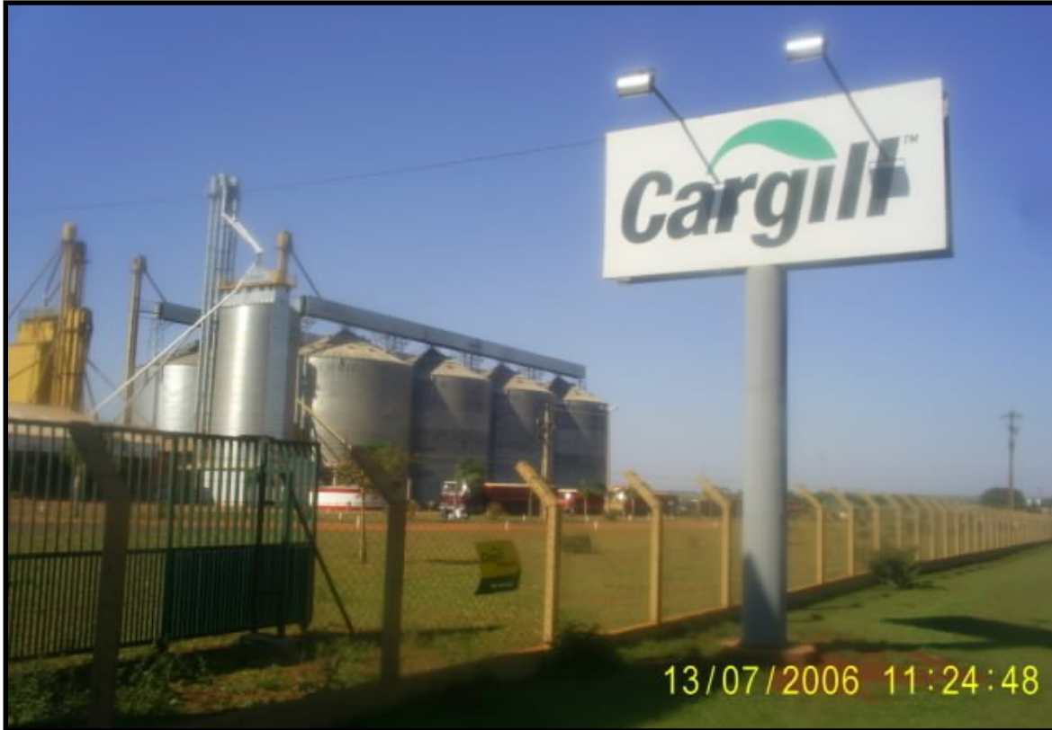
FIGURA – 07: Silo da Cargill no distrito de San Alberto.
