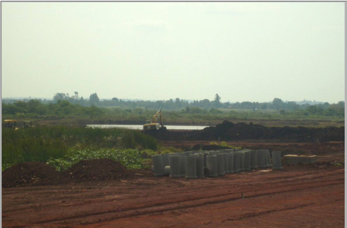
Foto 40 – Drenagem da área de construção do Parque
