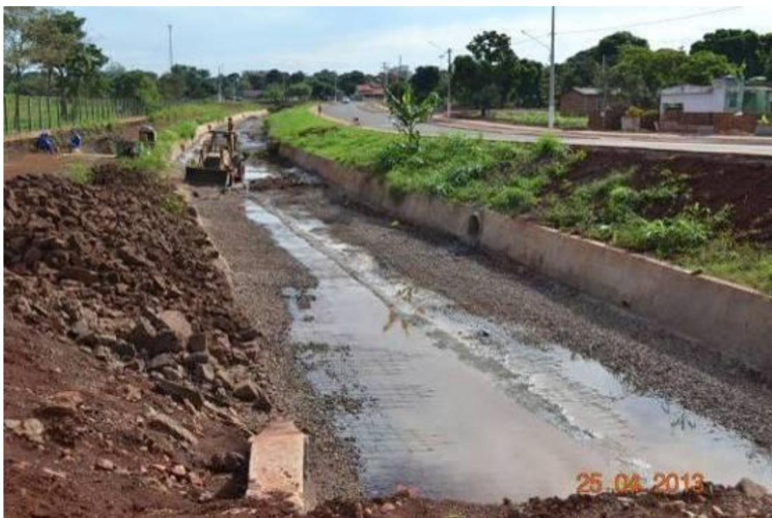
Figura 38 - Emparedamento do canal do Córrego Água Boa, no Jardim Clímax. Fonte: CAMPOS, B. F., 2013
