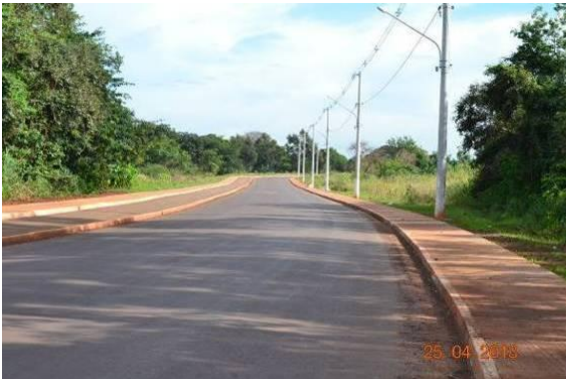
Figura 37 - Ligação viária entre a Avenida Aziz Rasslen e a BR 463. Fonte: CAMPOS, B. F., 2013.
