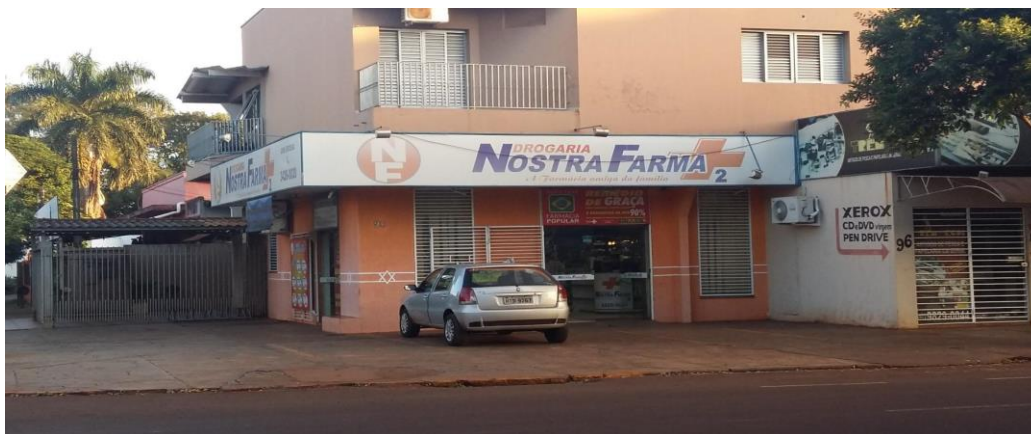
Figura 16 - Farmácia Antes da Reforma
