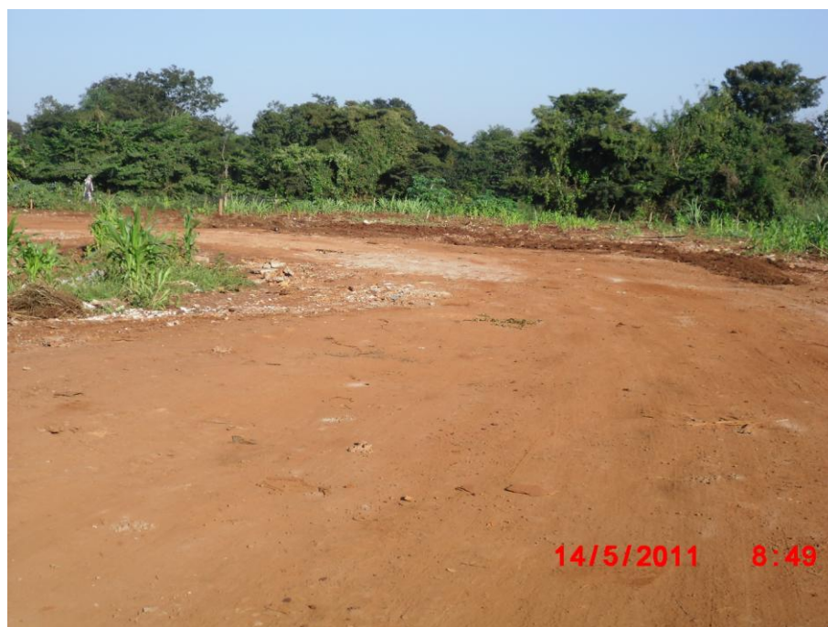
Foto – 19: Vista do aterro da Construforte. Foto: Jussara de Paula Almeida Marques.
