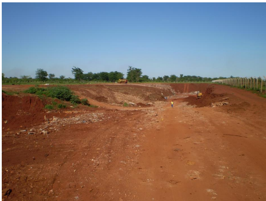
Foto - 16: Vista da entrada da área de disposição de RCC da empresa Transmito. Foto: Jussara de Paula Almeida Marques .
