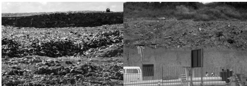
Figura 4: Aterro sanitário à esquerda; corte de um antigo lixão à direita.
