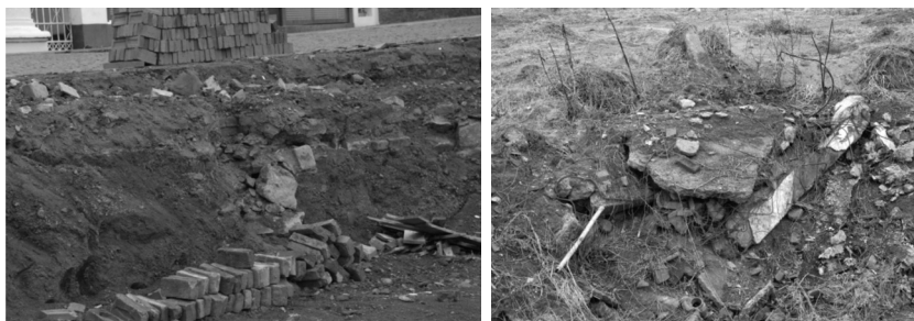
Figura 3: Restos de construção incorporados ao perfil de solo.
