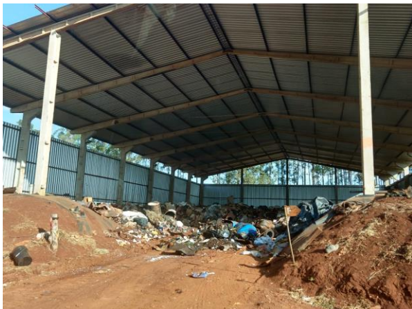
Figura 1 – Barracão coberto (empresa 2)
