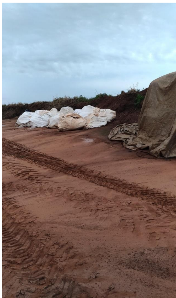
Figura 8. Apresentação do armazenamento de insumos.
