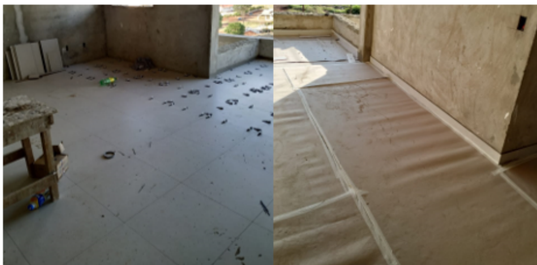
Figura 18 – Apartamento tipo antes (à esq.) e depois (à dir.) do V15
