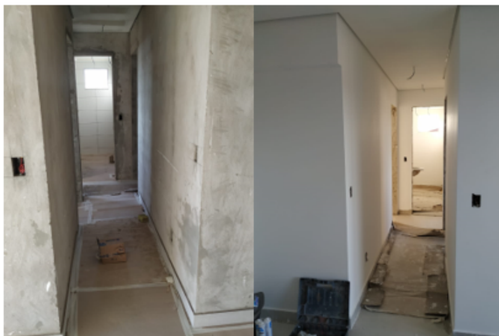
Figura 22 – Apartamento tipo antes (à esq.) e depois (à dir.) do V16
