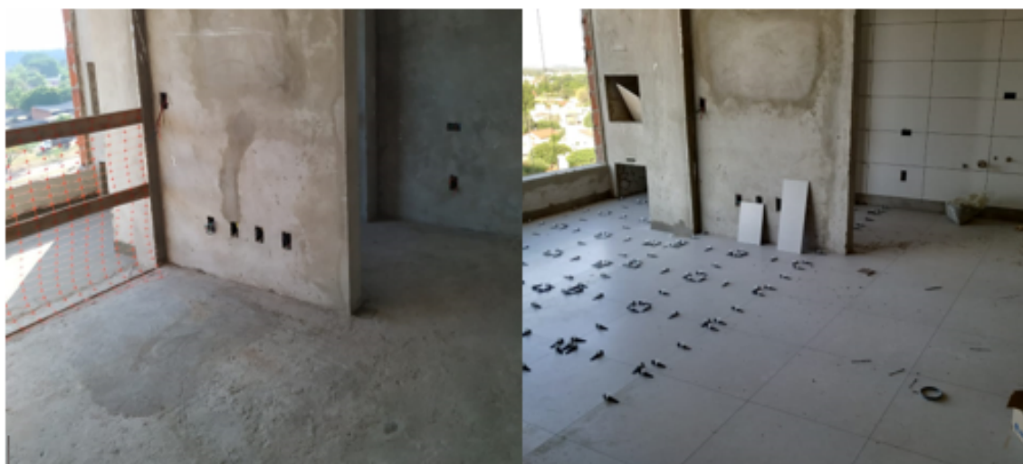
Figura 13 – Apartamento tipo antes (à esq.) e depois (à dir.) do V14
