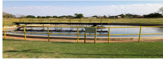
3.c - Decantador Secundário
