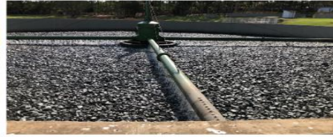
3.b - Filtro Biológico Aeróbico
