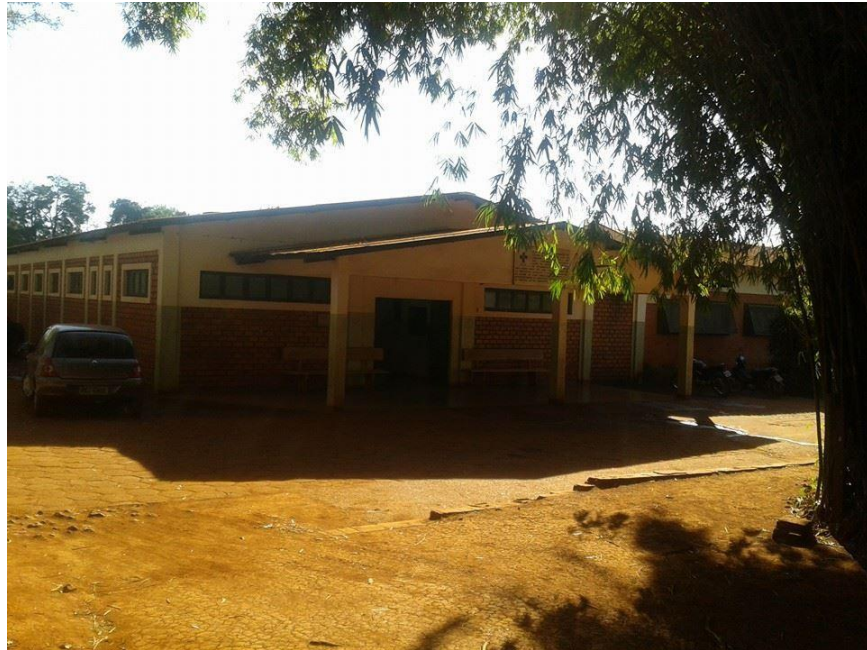
Figura 13: Entrada do Hospital.
