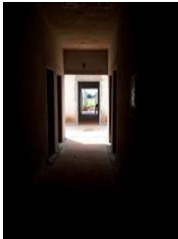
Figura 10: Corredor do posto saco de lixo.
