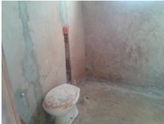
Figura 9: Banheiro em construção.
