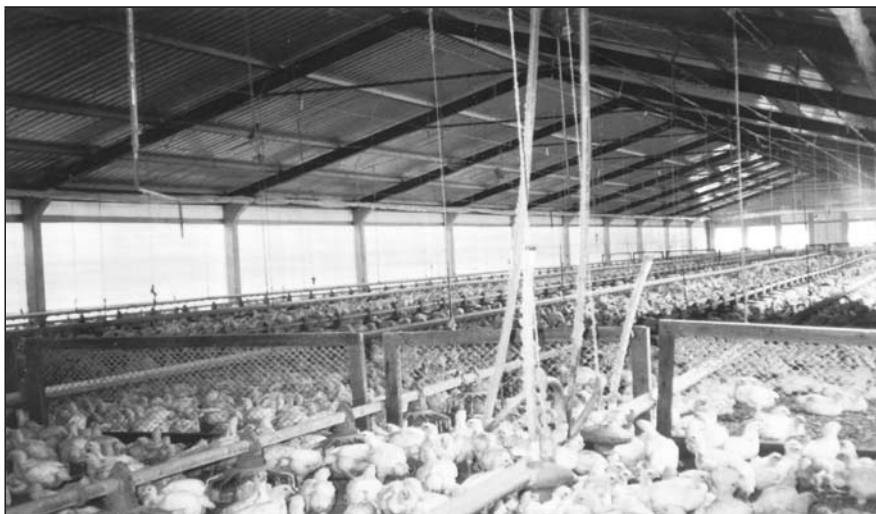
Foto 5 – Interior de um aviário climatizado
