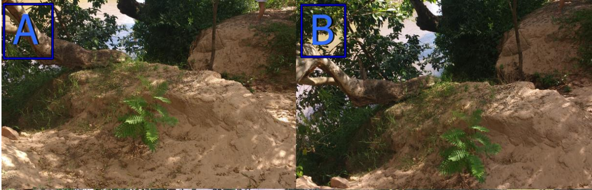
Figura 28. Ponto 2, próximo às margens do Rio Apa, área de risco por erosão do solo. Bela Vista - MS, 2017. A e B, Assoreamento do Rio provocado por erosão do solo.
