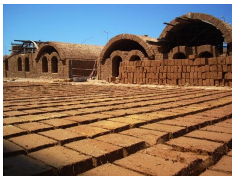
Figura 20: A imagem acima mostra os tijolos adobe produzidos e expostos ao sol. Fonte: < http://www.recriarcomvoce.com.br/blog_recriar/arquitetura-de-terra-ii/ > Acesso em 02/11/2015.
