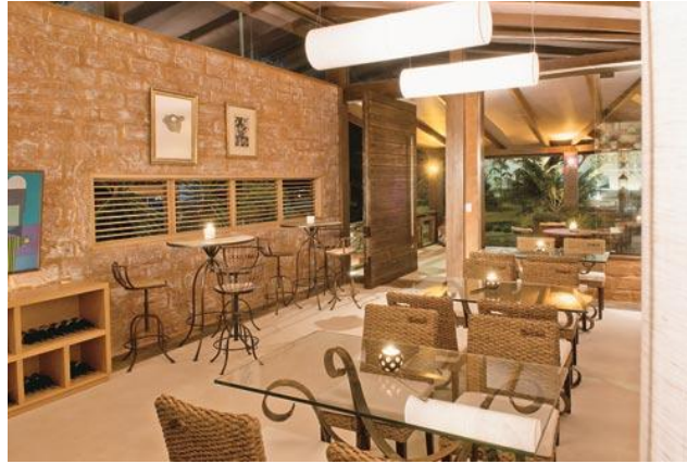
Figura 21: A imagem 21 mostra uma estrutura interior em que se utilizou o tijolo adobe como base para sua construção. < http://casa.abril.com.br/materia/casa-cor-brasilia-revitaliza-o-clube-do-servidor > Acesso em 02/11/2015.
