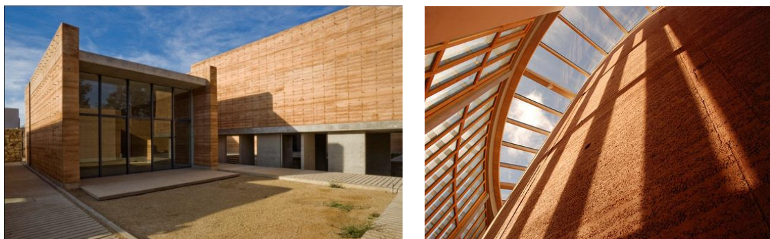
Figura 19: Acima dois exemplos de construções feitas com a técnica, à direita uma parede de terra curva com sete metros de altura e a esquerda a Escola Mexicana de Artes Visuais com suas estruturas de montagem expostas dando efeitos visuais na fachada semelhante a pontilhados. Fonte: < http://www.materialidade.com.br/blog/sustentabilidade/material-local-solucao-sustentavel/ > Acesso em 02/11/2015.
