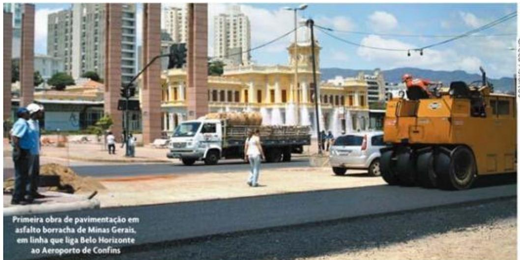
Figura 1: Primeira obra de asfalto-borracha em Minas Gerais/Brasil Fonte: [http://inovacao.scielo.br/scielo.php?script=sci\\_arttext&pid=S1808-23942007000300008&lng=es&nrm=is](http://inovacao.scielo.br/scielo.php?script=sci_arttext&pid=S1808-23942007000300008&lng=es&nrm=is)
