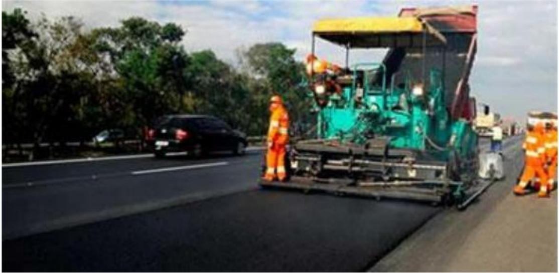
Figura 2: Aplicação do asfalto-borracha na rodovia dos Bandeirantes no trecho entre São Paulo e Campinas em 2011 Fonte: <http://www.hbsconstrutora.com.br/noticias-rodovia-dos-bandeirantes-tera-pavimentoecologico-entre-sao-paulo-e-campinas.html>
