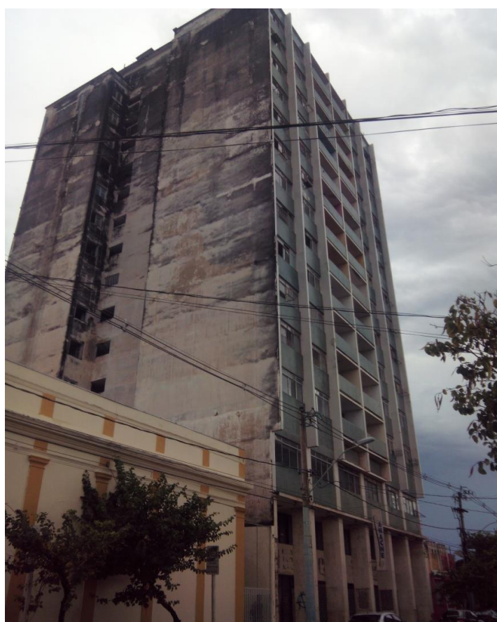
APÊNDICE R – Edifício central abandonado. Corumbá – MS, 2014.
