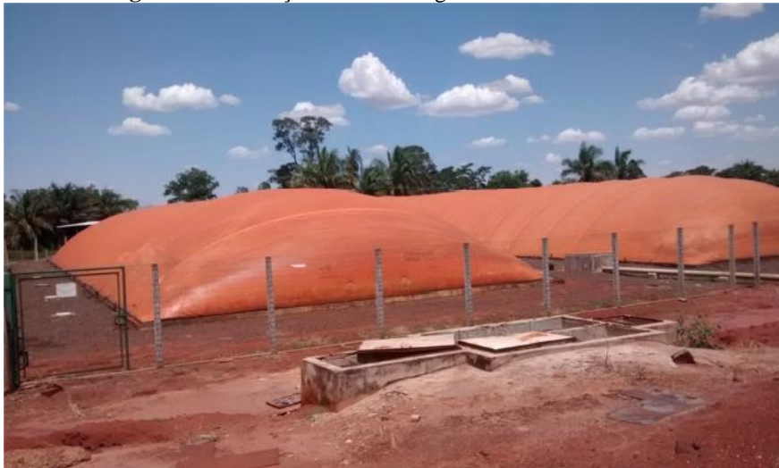
Figura 10: Ilustração de um biodigestor modelo canadense.
