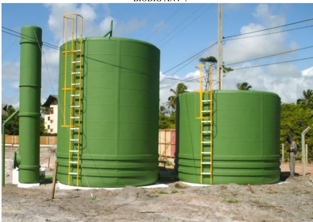
Figura 14: Exemplo de reator anaeróbico de fluxo ascendente – UASB, comercialmente chamado de “BIODIG ANV”.
