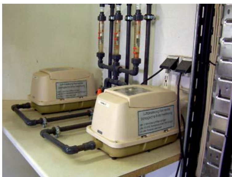
Figura 28: Controle de gás para sopramento de ar no gasômetro em biodigestor [DBFZ].
