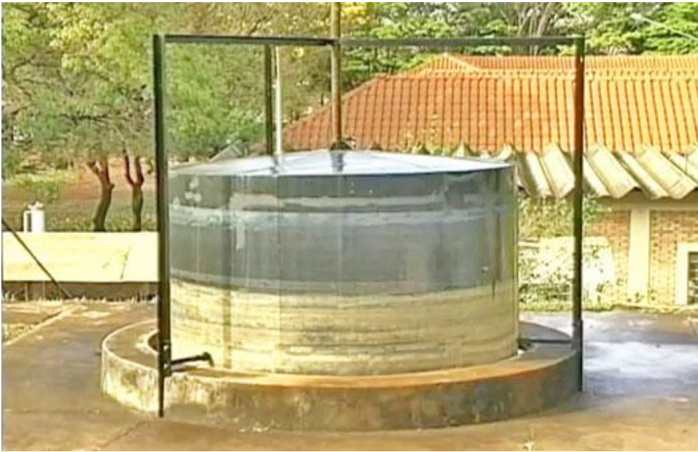
Figura 6: Exemplo de biodigestor descontínuo – batelada.
