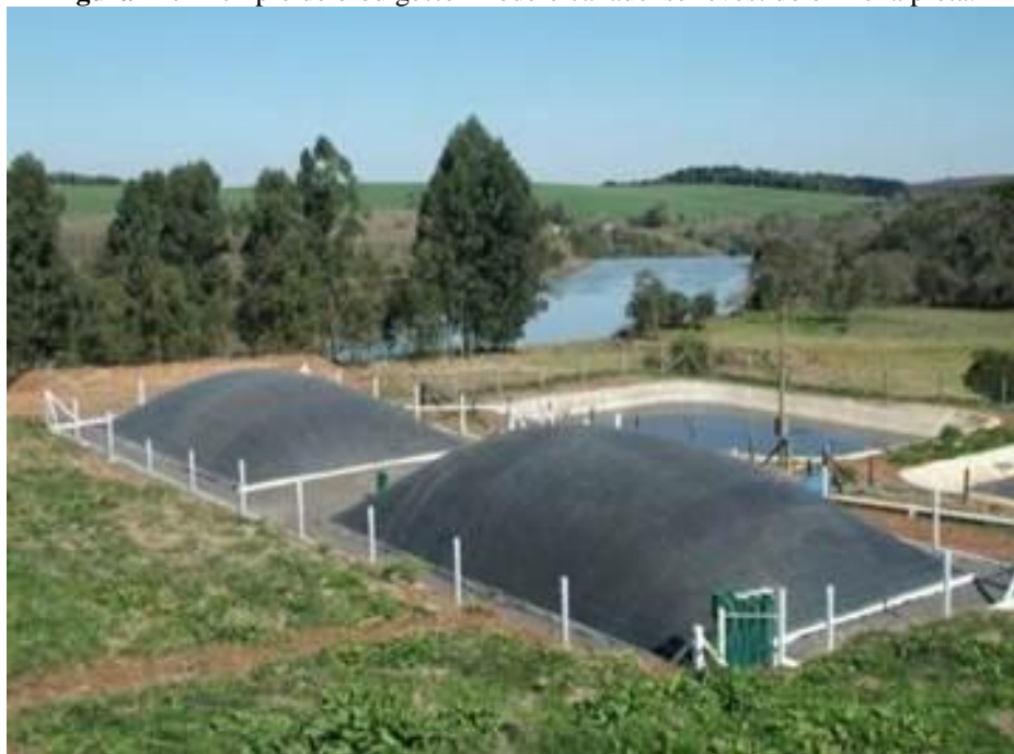
Figura 12: Exemplo de biodigestor modelo canadense revestido em lona preta.
