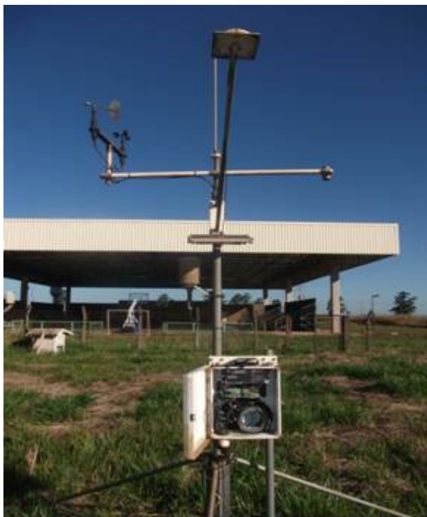
Figura 5 - Estação meteorológica instalada no campus II da UFGD.
