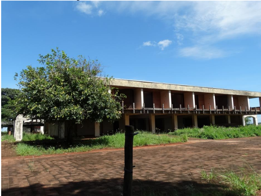
Foto 5. Fachada da antiga sede da Fazenda Itamarati.
