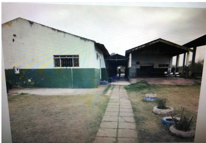
Figura 5. Faixada da Escola Rural Polo Eutrópia Gomes Pedrosa
