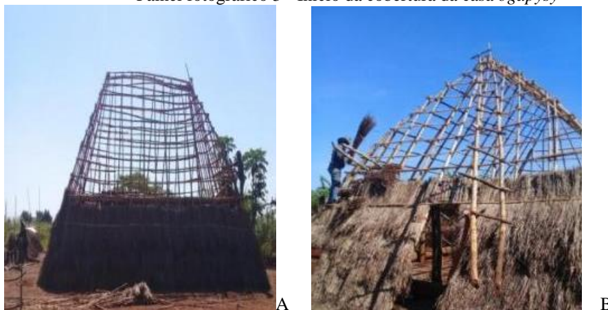
Painel fotográfico 3- Início da cobertura da casa ogapysy
