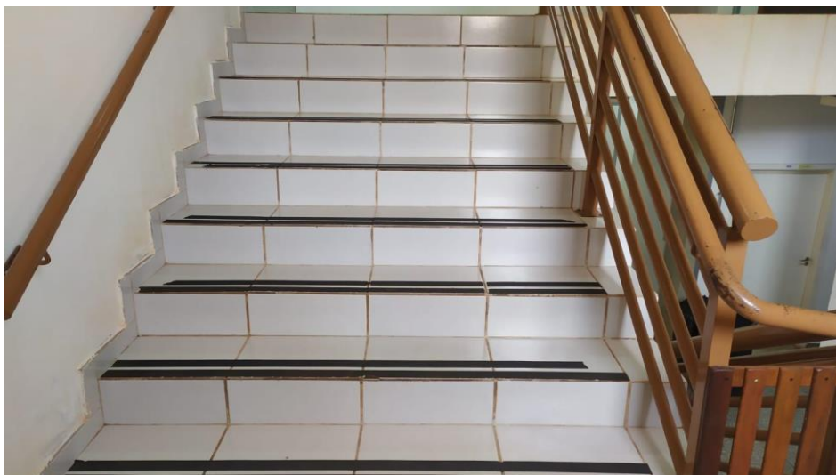
Figura 9 – Escada da Edificação
