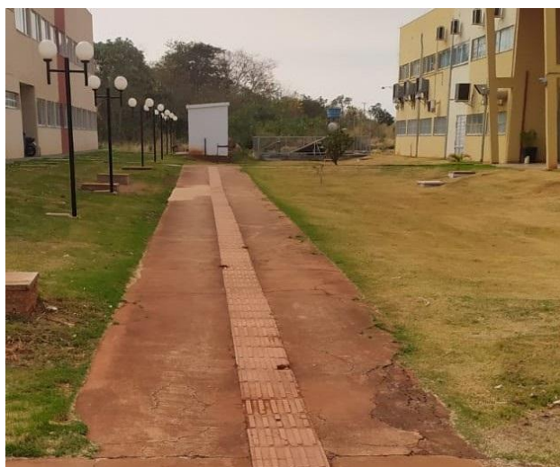
Figura 2 - Piso tátil não atende aos requisitos
