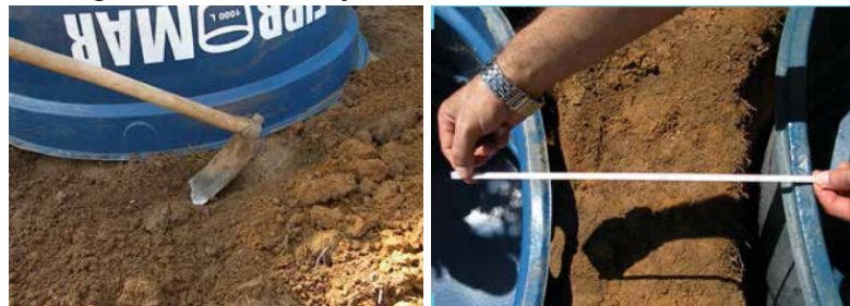
Figura 02 - Demarcação do local a ser escavado
