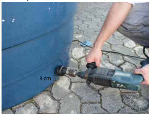
Figura 04 - Execução do furo inferior com a furadeira serra-copo
