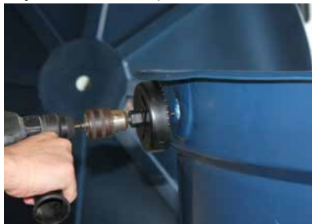
Figura 03 - Execução dos furos superiores com a furadeira serra-copo
