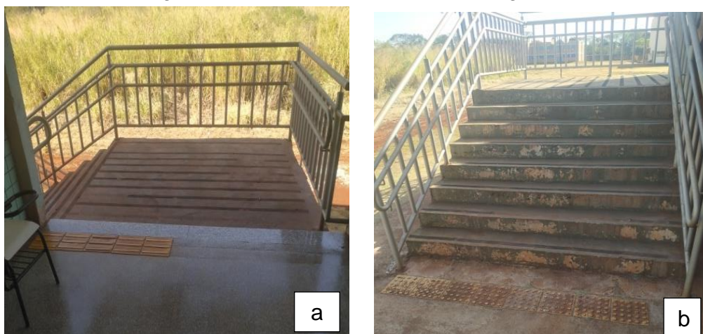
Figura 11 - Detalhe da Escada de Emergência
