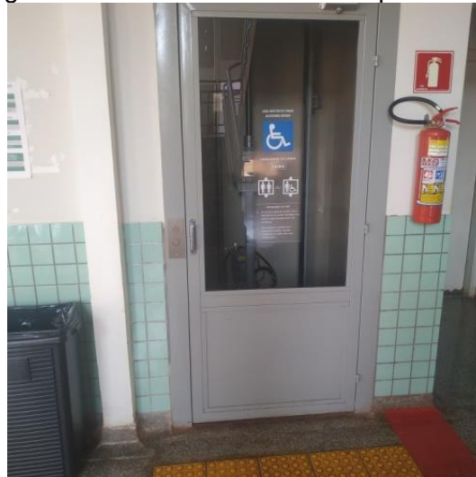
Figura 8: Entrada do Elevador no piso térreo.
