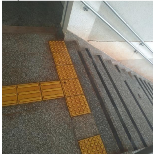
Figura 6: Detalhe do piso tátil de alerta existente na escada interna.
