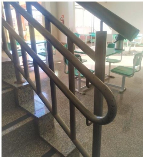
Figura 5 - Detalhe da escada interna.
