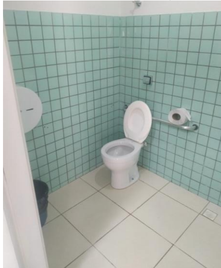
Figura 13 – Sanitário feminino localizado no térreo, detalhamento da bacia sanitária.
