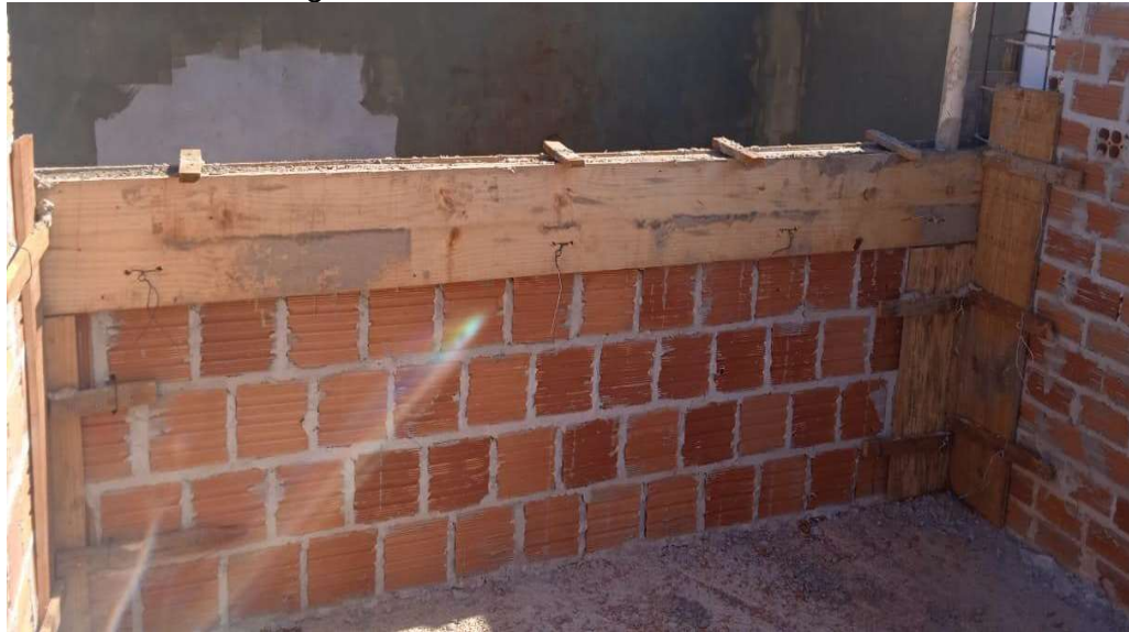
Figura 1 - Alvenaria de meia vez.
