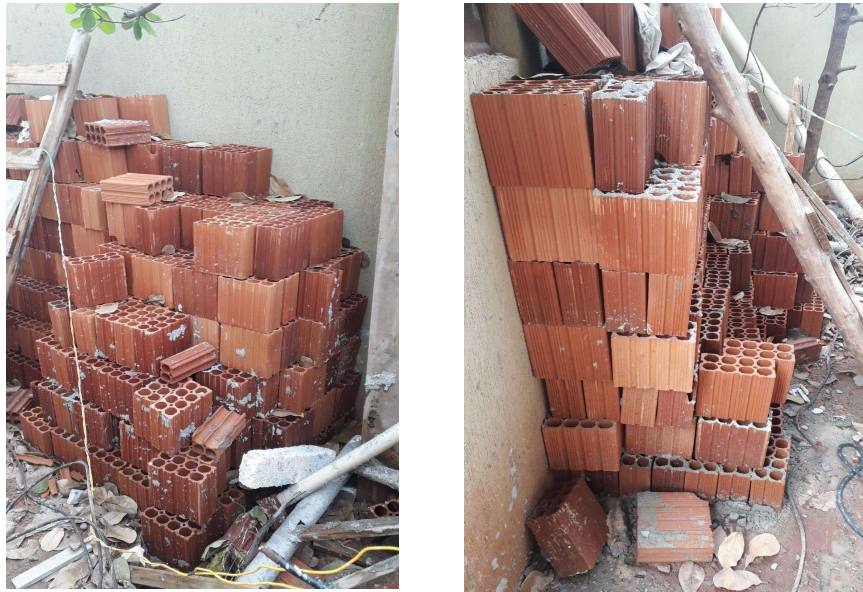
Figura 3 - Exemplos de má estocagem dos tijolos.
