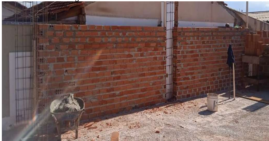
Figura 2 - Alvenaria de uma vez.
