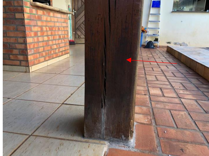
Figura 12 – Várias Rachaduras
