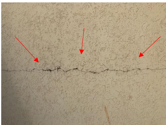
Figura 3 – Fissuras Horizontal
