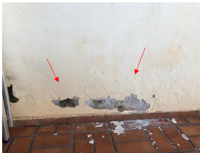
Figura 14 - Infiltração rodapé
