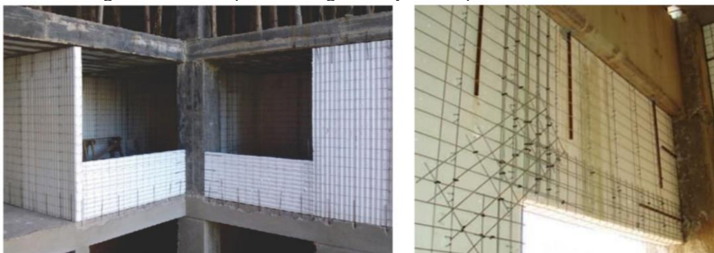
Figura 4 - Arranques em vigas e lajes dos painéis monolíticos
