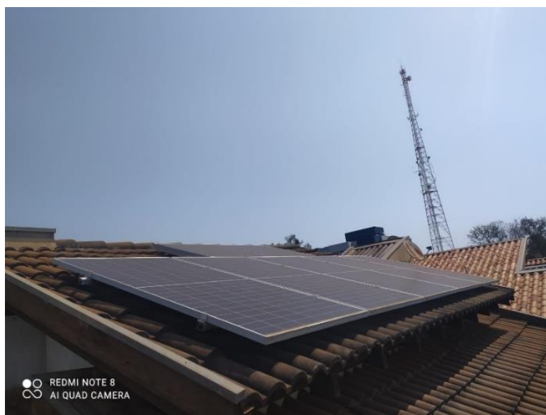
Figura 7: Segundo arranjo de módulos fotovoltaicos
