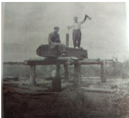
Figura 17 - Técnica empregada por paraguaios para serrarem troncos grandes.
