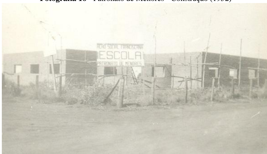
Fotografia 16 - Patronato de Menores - Construção (1952)
