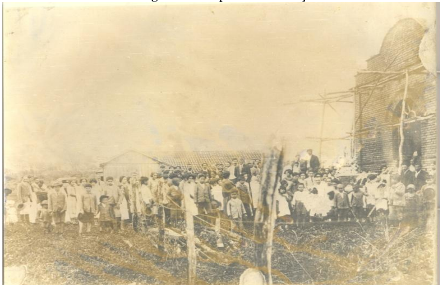
Fotografia 4 - Capela em construção
