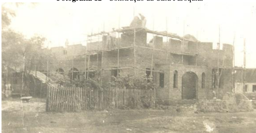
Fotografia 12 - Construção da Casa Paroquial
