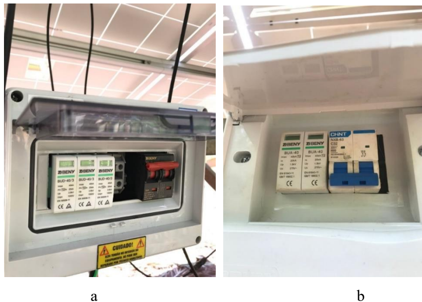
Figura 20. String box CC (a) e String box CA (b)
