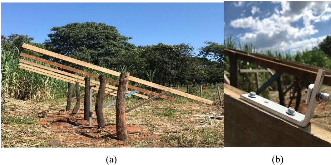
Figura 17. Suporte de madeira (a) e perfil em L (b) utilizados para fixação dos módulos.
