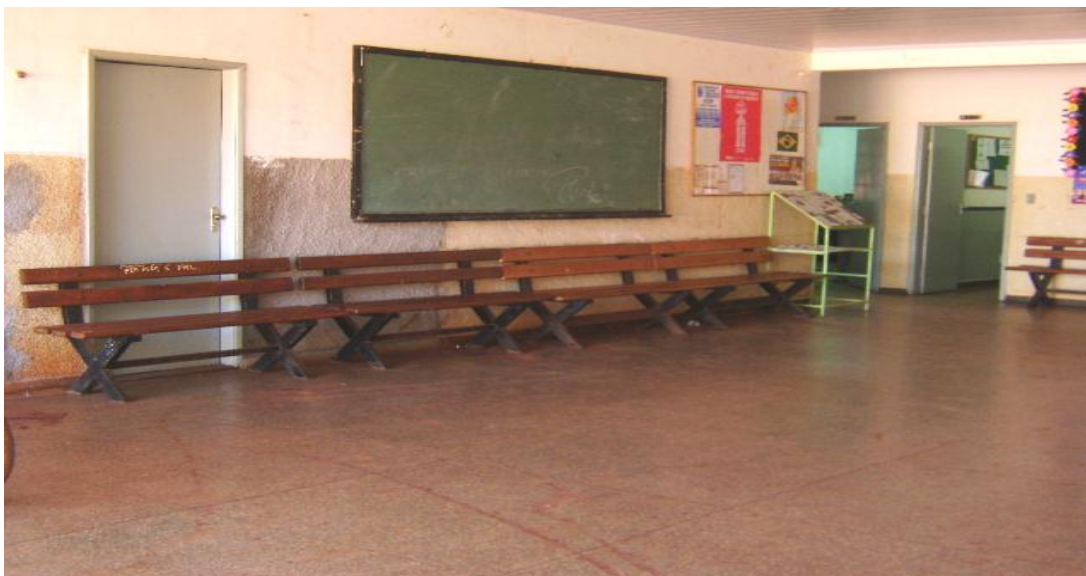
Figura 3 – Hall da Escola I
