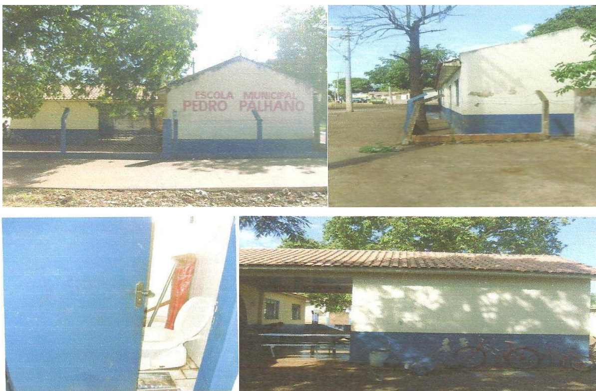
Imagem 10- Fotos da escola antes da reforma no ano de 2010
