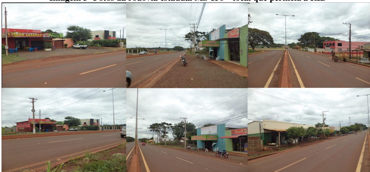
Imagem 3- Fotos da rodovia estadual MS 156 – local que permeia a RID
