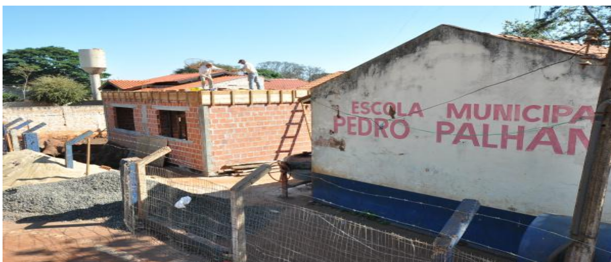
Imagem 11- Foto da escola durante a reforma no ano de 2012
