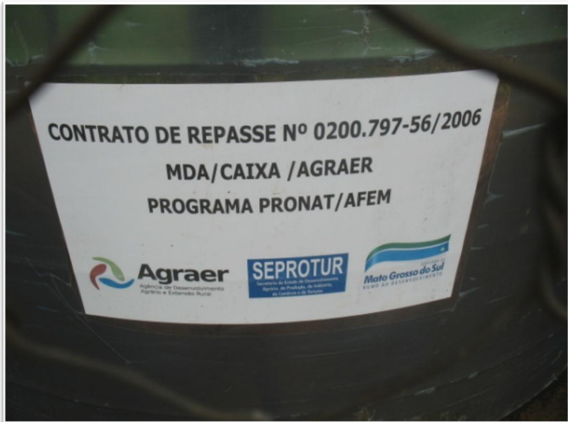
Foto 2: Mostra de resfriadores de leite, instalados em assentamento. Caso do assentamento Santa Irene, Município de Anaurilândia- MS
