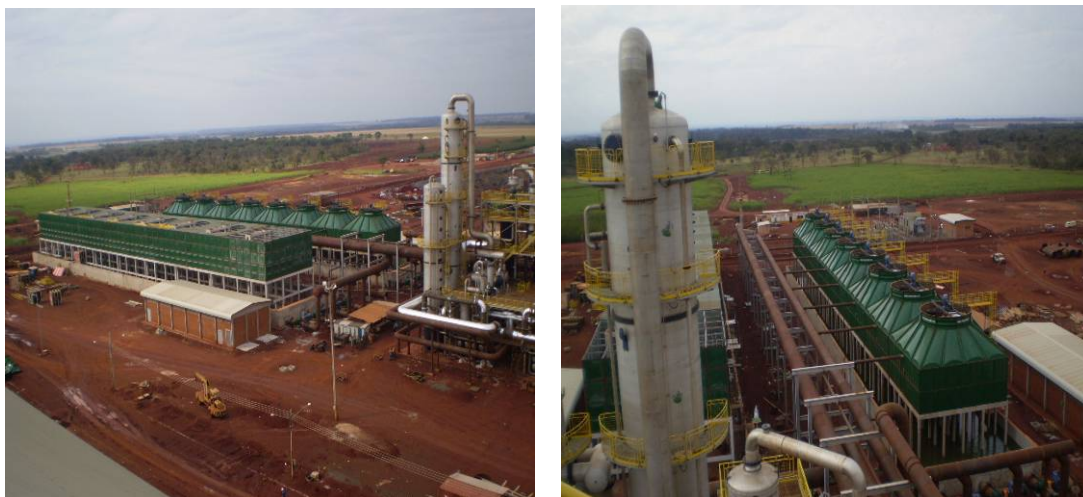
FIGURA 28 E 29: TANQUE DE RESFRIAMENTO DA LDC BIOENERGIA S/A - UNIDADE RIO BRILHANTE
