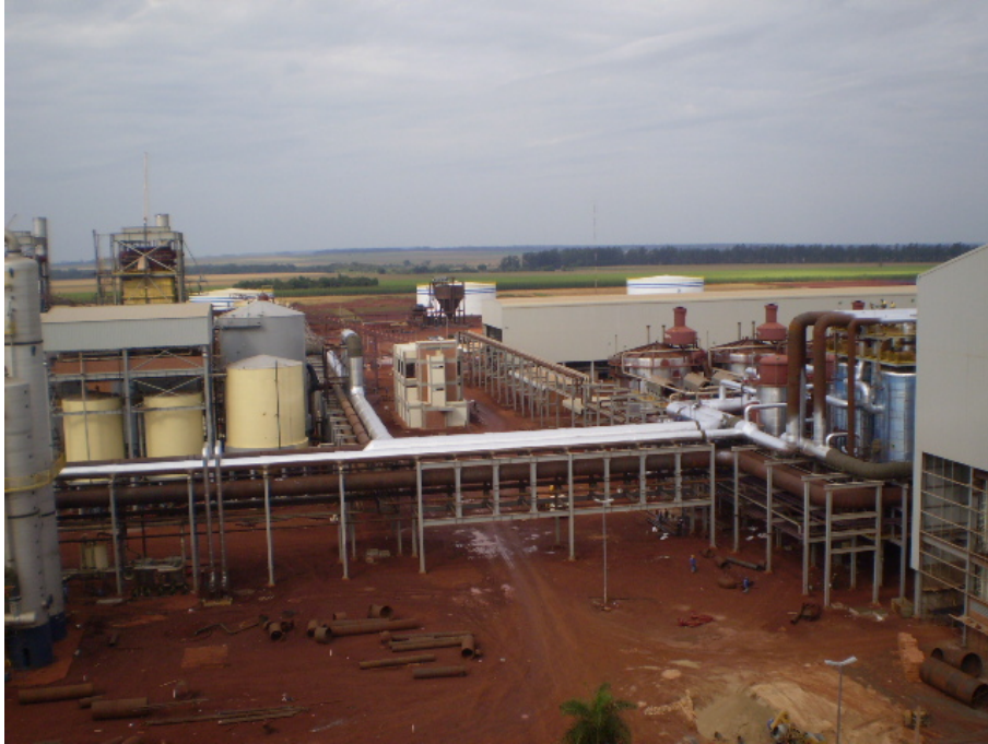
FIGURA 10 – LDC BIOENERGIA S/A – UNIDADE RIO BRILHANTE EM CONSTRUÇÃO 2007 – RIO BRILHANTE/MS (II)
