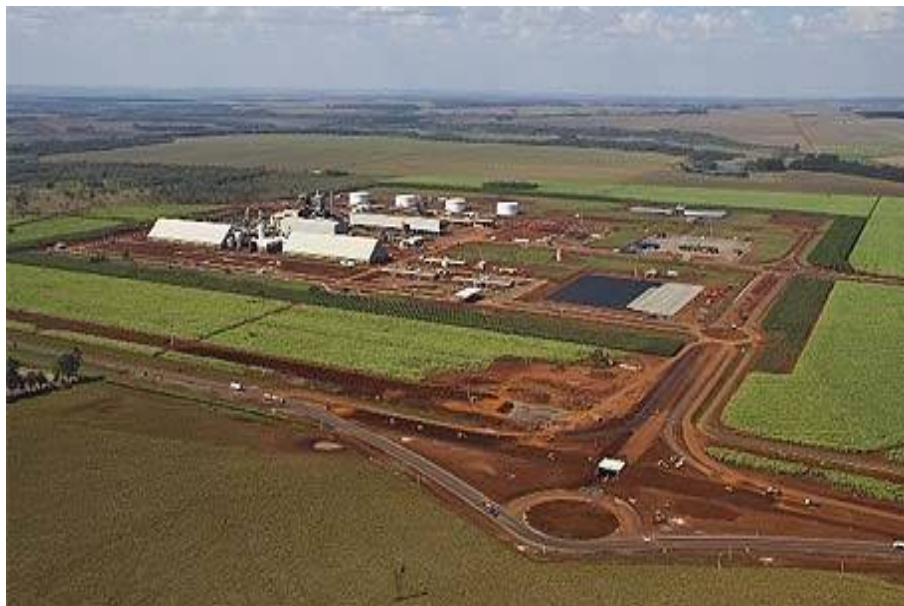
FIGURA 09 – LDC BIOENERGIA S/A – UNIDADE RIO BRILHANTE EM CONSTRUÇÃO 2007 – RIO BRILHANTE/MS (I)
