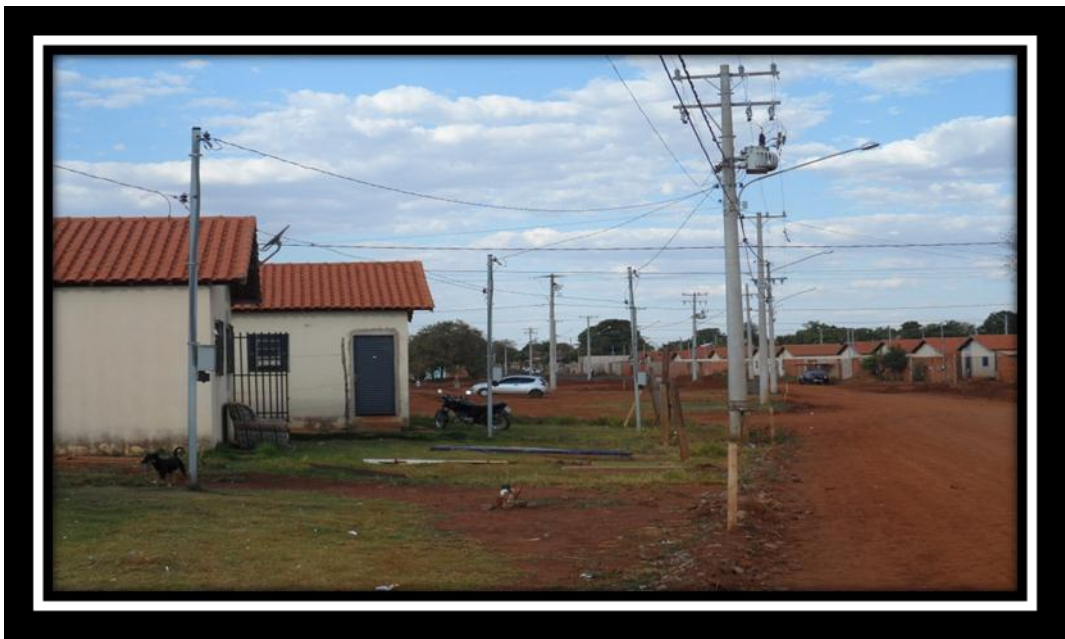
Foto 07 – Ausência de infraestrutura urbana – Residencial Ramez Tebet
