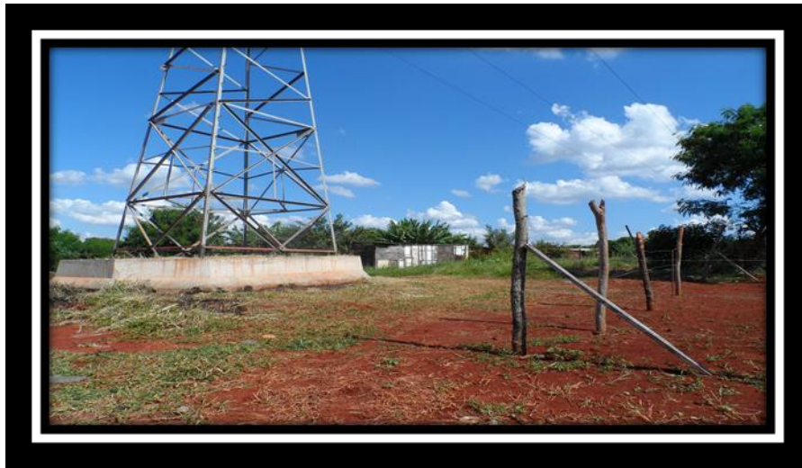
Foto 06– Aspectos da Favela da Alta Tensão
