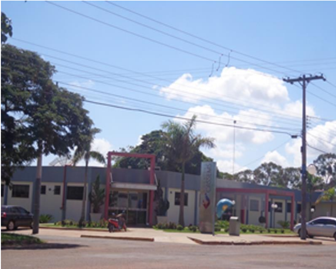
Figura 9 – Hospital da Cassems unidade de Ponta Porã. Foto: DOKKO (2014).
