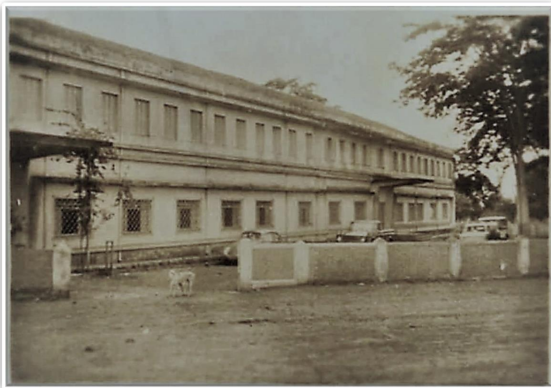
Foto 19: Fachada central Instituto Educacional de Dourados. Ano: Década de 1970.
