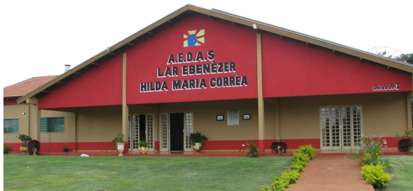
Figura 12. Entrada principal do Lar Ebenézer onde ficam as meninas abrigadas
