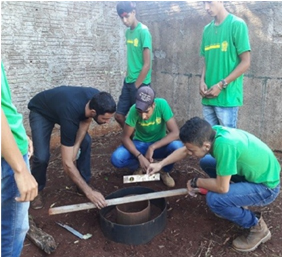
Figura 5.2: Nivelamento dos cilindros.
