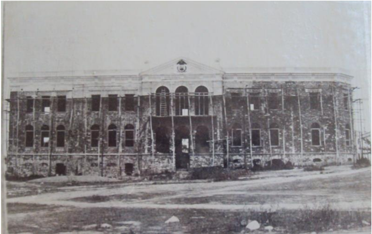
Figura 8 – Grupo Escolar Luiz de Albuquerque em obras, na década de 1910 Fonte: Acervo da Biblioteca Municipal de Corumbá, 1910
