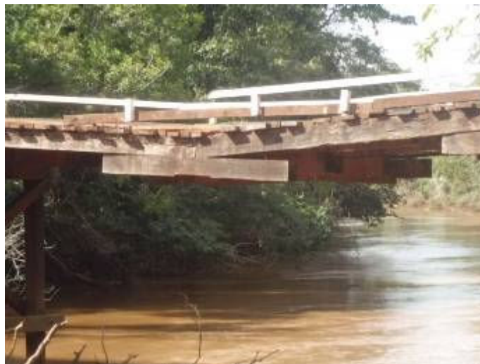
Figura 8 – Rio Anhanduí e ponte de acesso à Escola Polo. Fonte: Arquivos do autor (2014).
