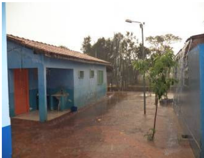
Figura 16 – Alojamento atual da escola do campo. Fonte: Arquivos do autor (2014).
