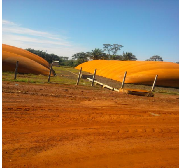
Figura 7 - Biodigestor modelo canadense.
